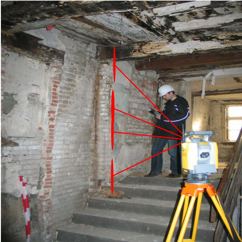
Bauteilmessung am Bestand
